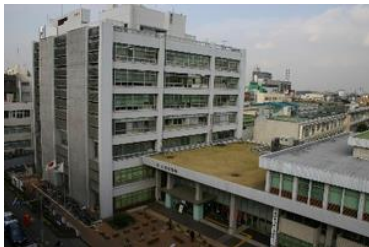
▲耐震性に欠ける現大宮区役所は建替えが急務。震度6強で倒壊の恐れあり。
