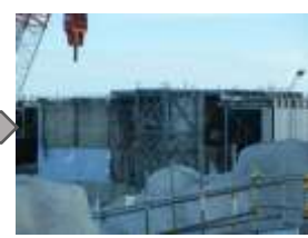
1号機解体作業が進む現場
