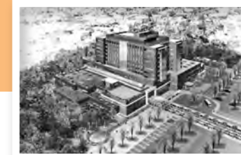
現在県立がんセンターは新病院を建設中（伊奈町）。平成25年12月オープン予定。増床（400床→500床）、手術室増設（7室→12室）、国内最大規模の外來用化学療法ベッド（60床）など、充実が図られる。
